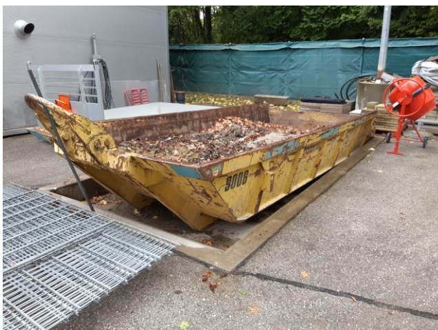
Fosse et benne actuelle pour récupération des balayures
